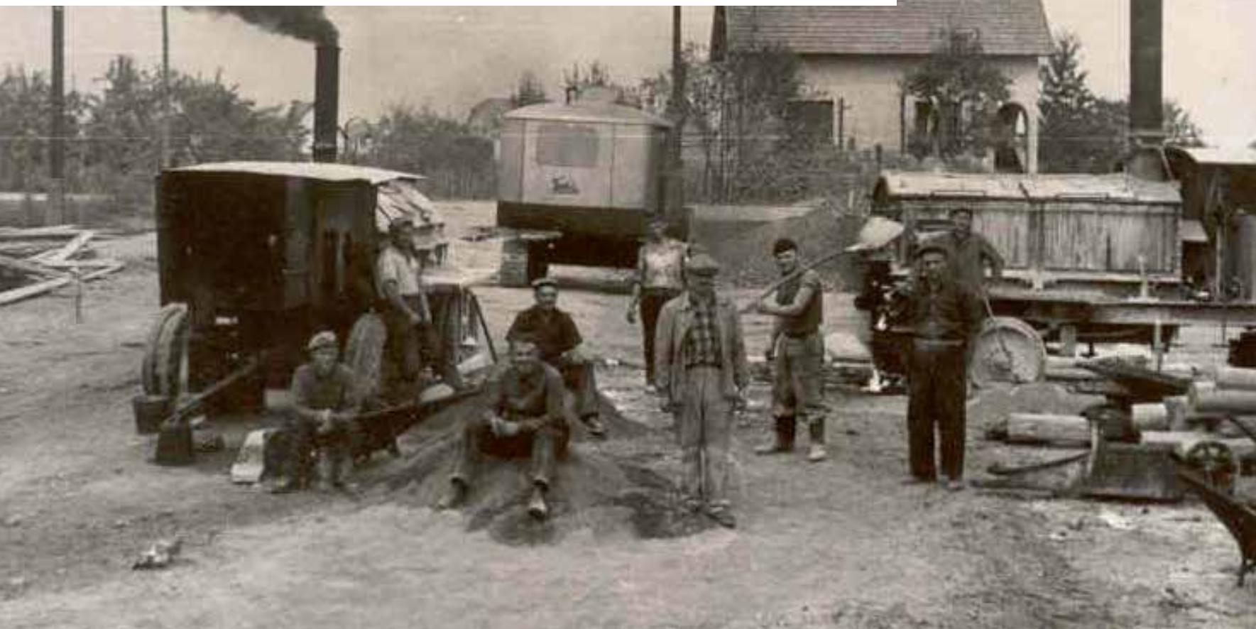
Polaganje temeljev za Centralno skladišče Ljubljana leta 1954
