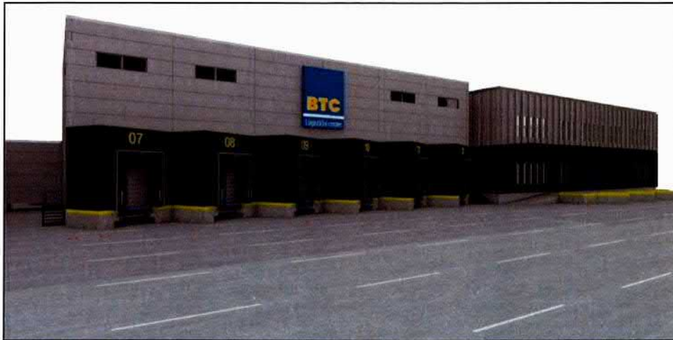
Slika: Nov objekt E1 in načrtovana osvežitev starejših fasad v Logističnem centru
